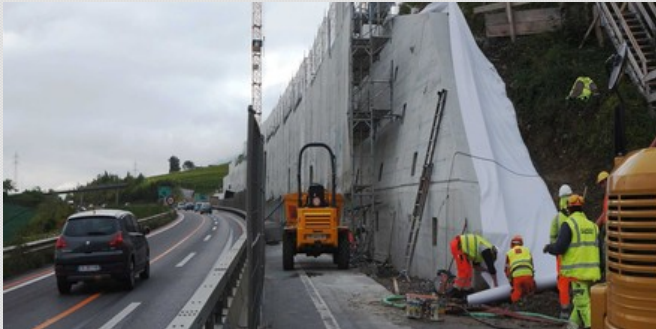
Pumpbeton C30/37, frostausalzbeständig, Körnung 0-8 mm
